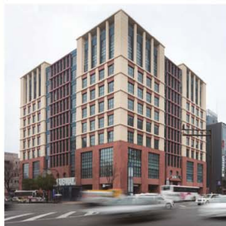
呉服町ビジネスセンター
