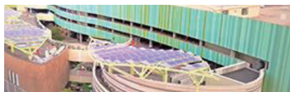
太陽光発電システム
