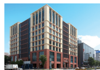
呉服町ビジネスセンター
