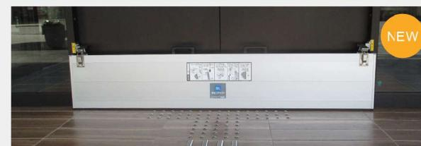
台風時のエントランスへの水侵入を防止するため、止水板新設及び入口側面へ自動扉設置
