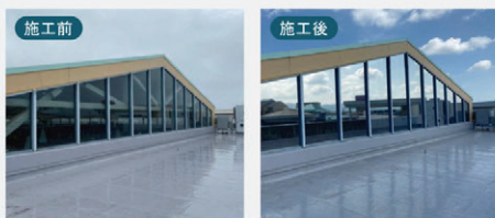
パークプレイス大分フードコートトップライト部遮熱シート施工
