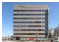
熊本イーストフロントビル
